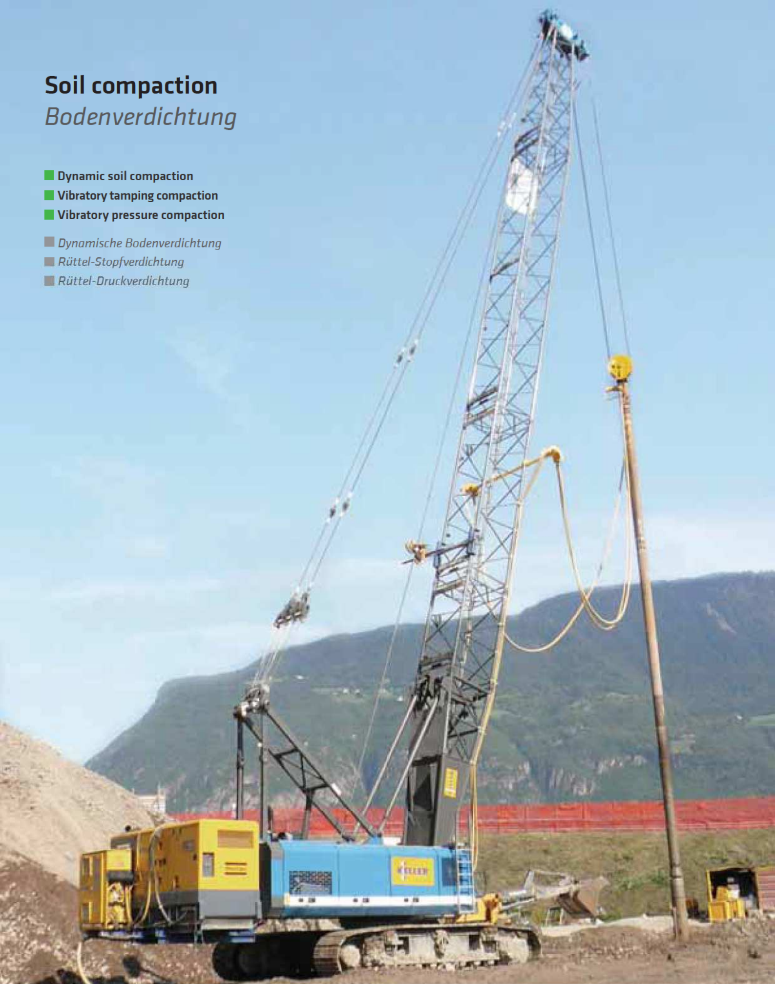
660 HD - Construction of tamped columns via vibratory tamping compaction; Italy 660 HD - Herstellen von Stopfsäulen mittels Rüttel-Stopfverdichtung; Italien
