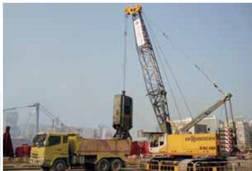
690 HD - With mechanical diaphragm wall grab; Hong Kong 690 HD - Mit mechanischem Schlitzwandgreifer; Hong Kong
