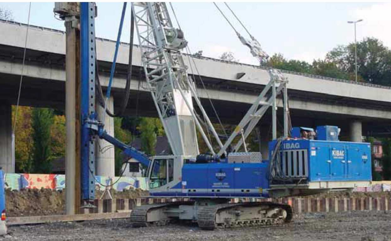
680 HD - With Power Pack, hydraulic ram and hydraulic hammer; Switzerland 680 HD - Mit Aggregat, hydraulischer Ramme und hydraulischem Hammer; Schweiz
