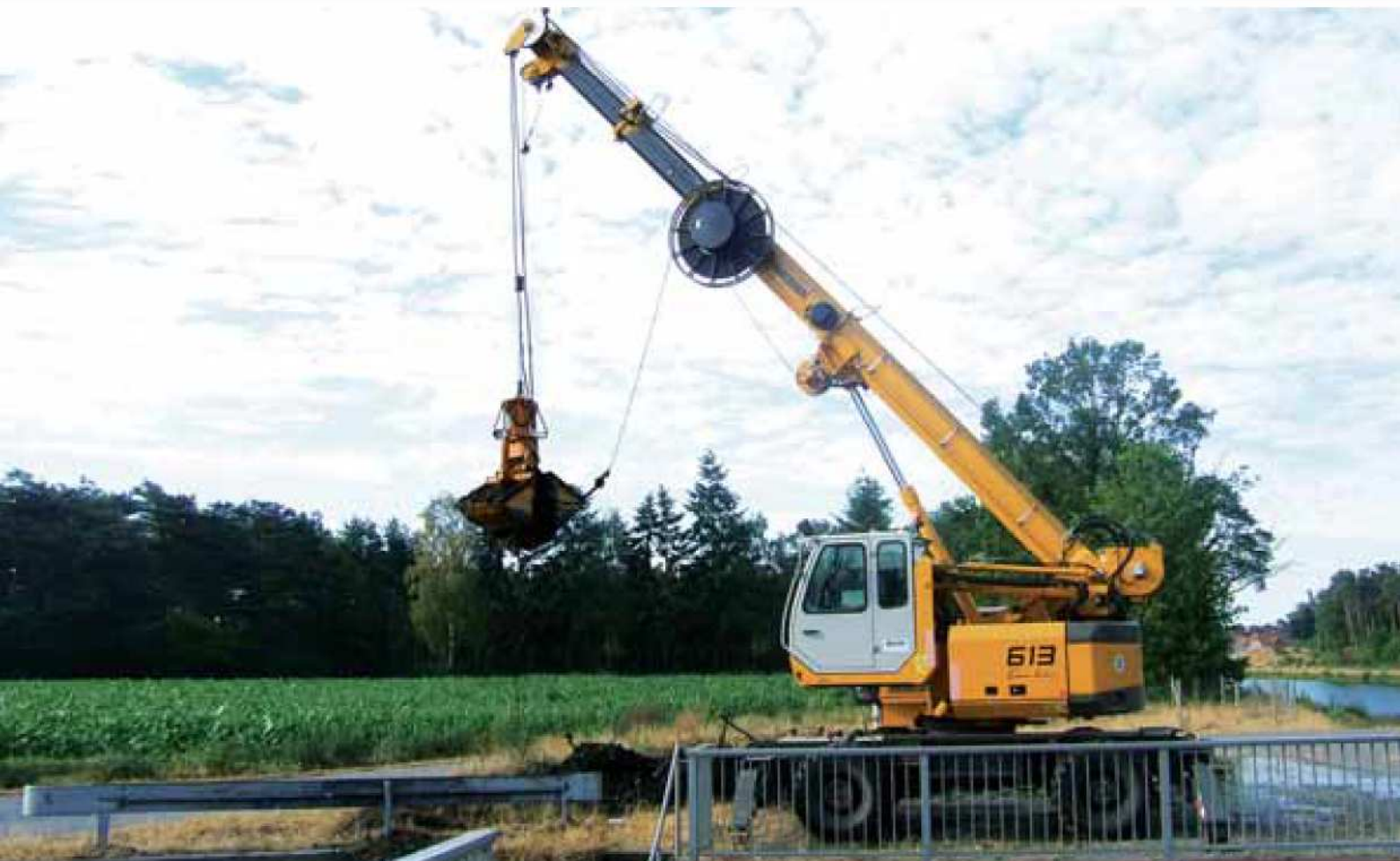
613 M – Clamshell operation in hydraulic construction; Germany 613 M – Zweischalengreiferbetrieb im Wasserbau; Deutschland
