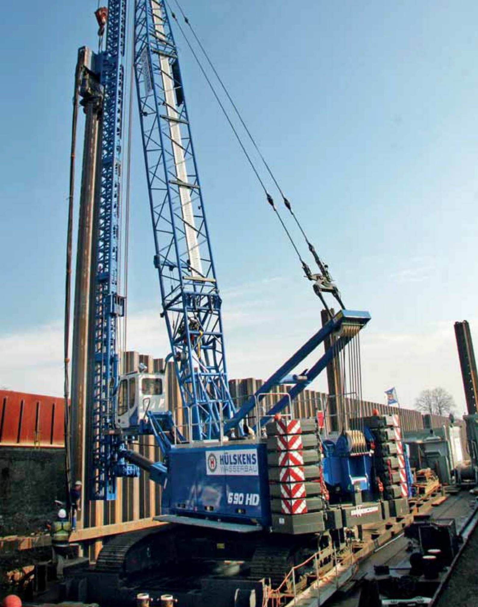
690 HD - Hydro construction with leader; Germany 690 HD - Wasserbaueinsatz mit Mäkler; Deutschland
