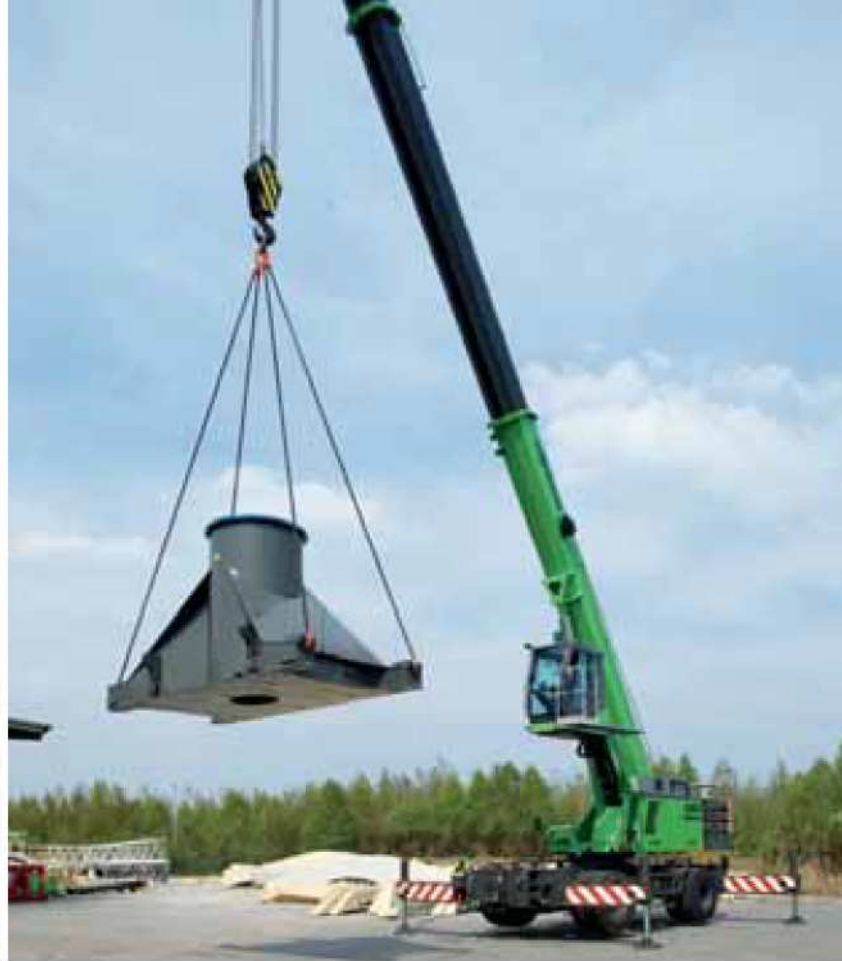
683 M - Yard crane works; Germany 683 M - Lagerplatz-Hebearbeiten; Deutschland
