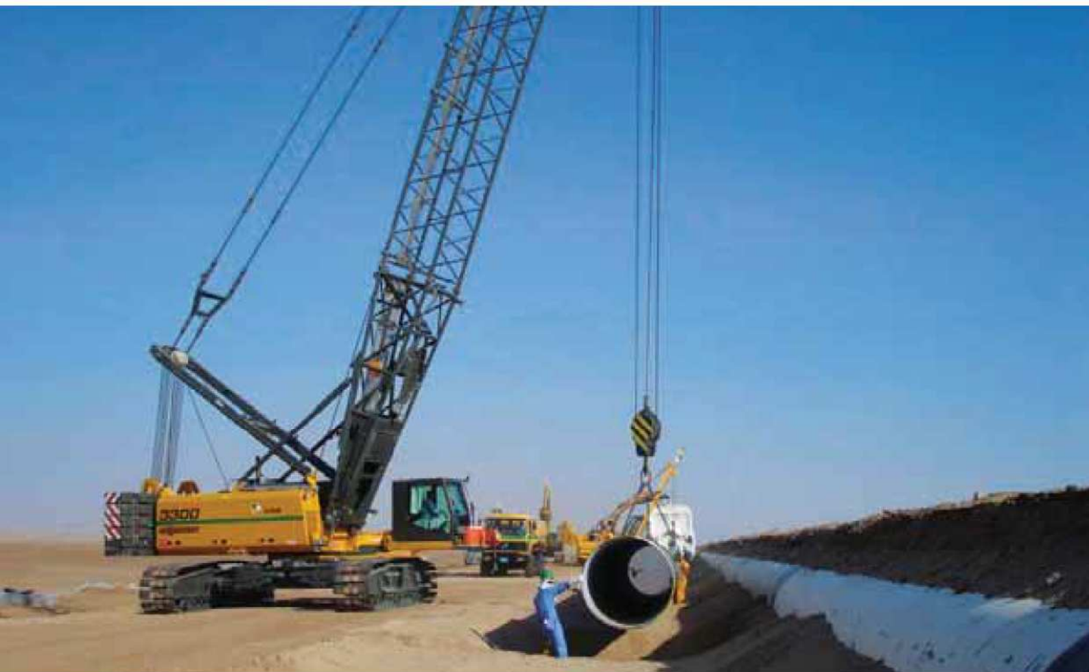
3300 - Positioning of tubes for pipeline construction with main boom; Saudi Arabia 3300 - Positionierung von Rohren beim Pipeline-Bau mit Hauptausleger; Saudi Arabien
