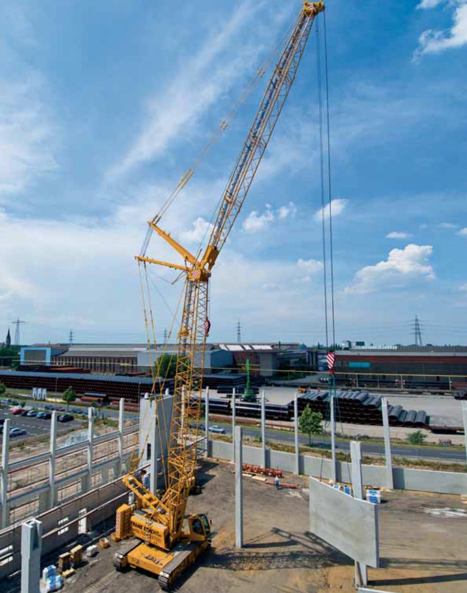
4400 - Concrete-prefabricated parts installation; Germany 4400 - Beton-Fertigteilmontage; Deutschland
