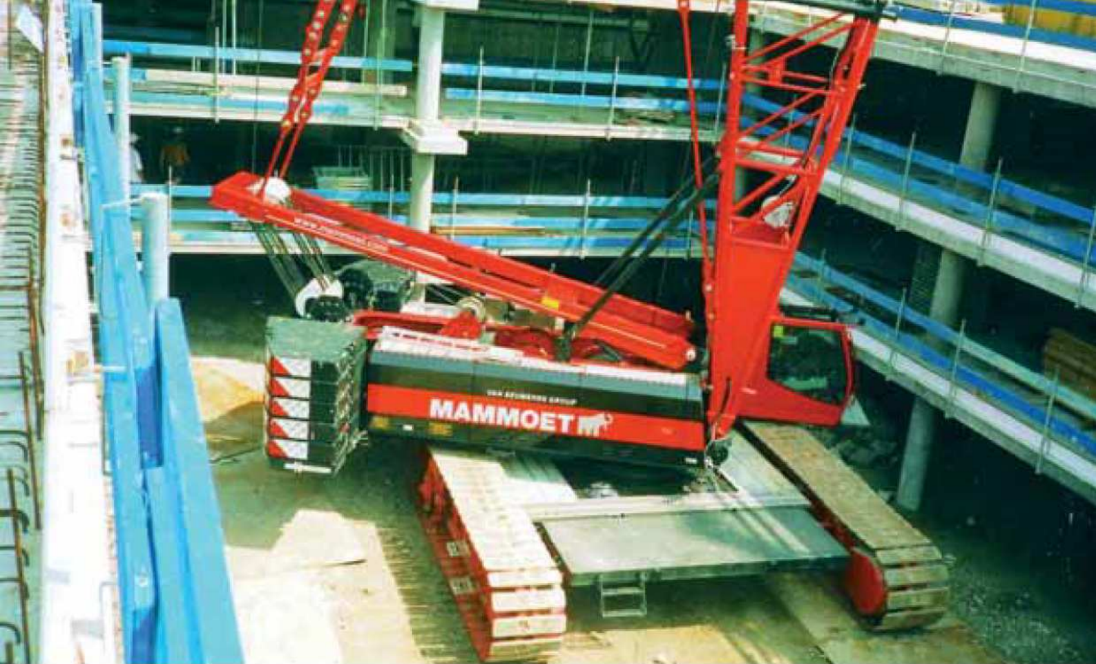
5500 - Hoisting works of concrete-prefabricated parts; Netherlands 5500 - Hebearbeiten von Beton-Fertigteilen; Niederlande
