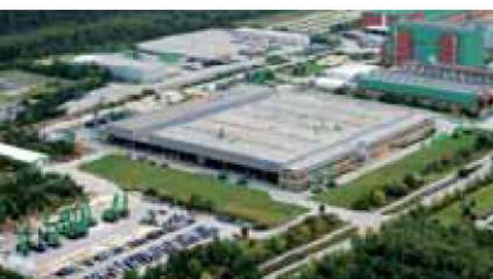
Works Wackersdorf - production Green Line series machines Werk Wackersdorf - Produktion Green Line Seriengeräte
