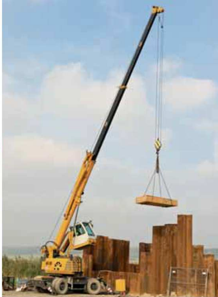
613 M – Hoisting works on construction site; Germany 613 M – Hebearbeiten auf Baustelle; Deutschland
