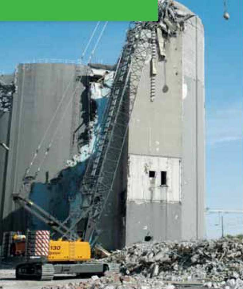
6130 HD – Demolition works with wrecking ball; Netherlands 6130 HD – Einsatz mit Abrissbirne; Niederlande
