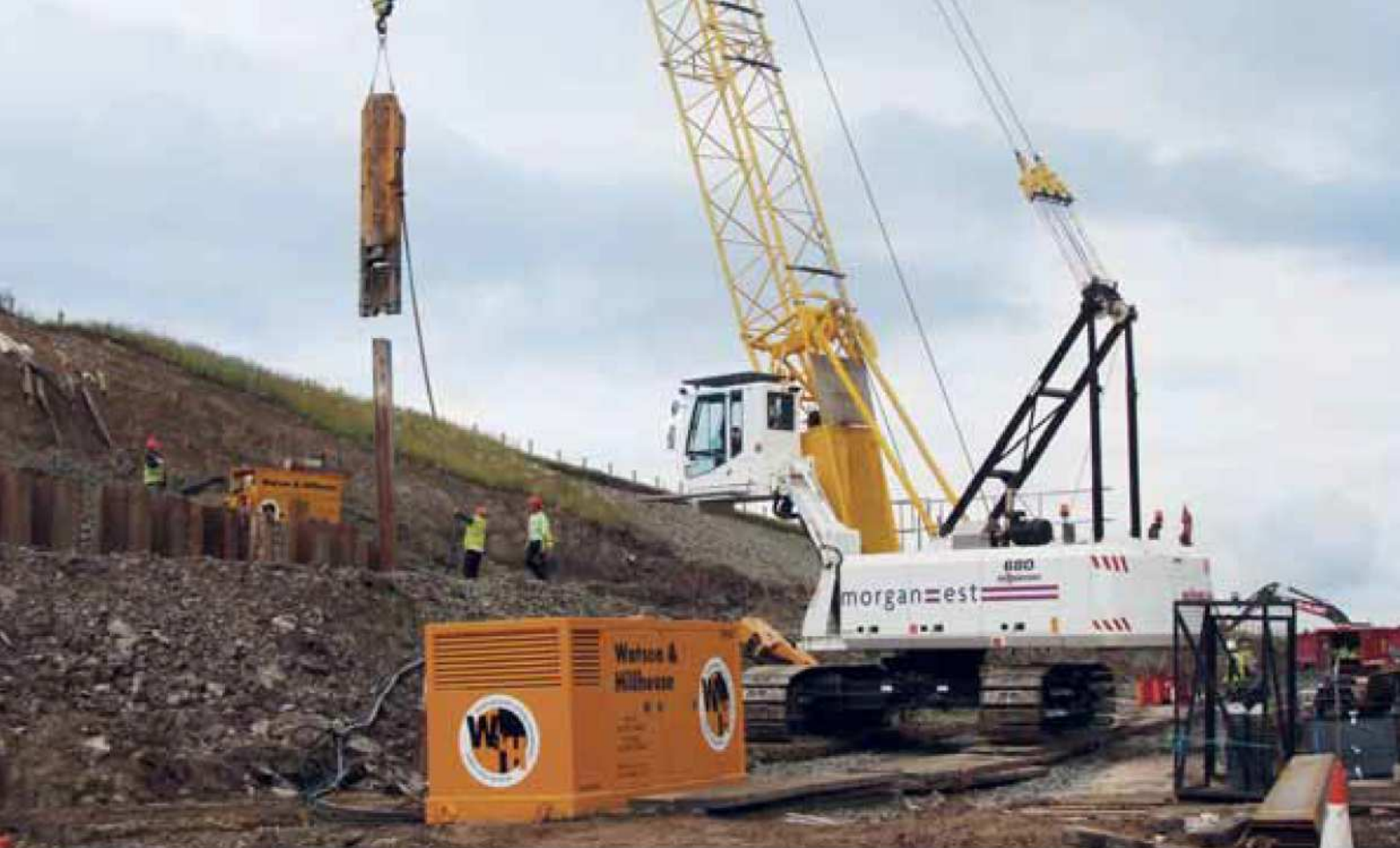
680 HD - Piling; Great Britain 680 HD - Rammeinsatz; Großbritannien
