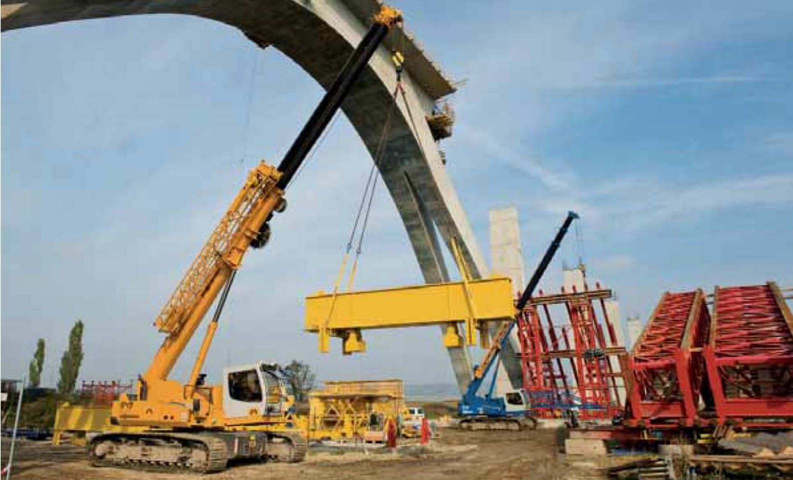
2 x 643 R - hoisting steel elements for bridge construction works; Germany 2 x 643 R - Hebearbeiten von Stahlfertigteilen im Brückenbau; Deutschland
