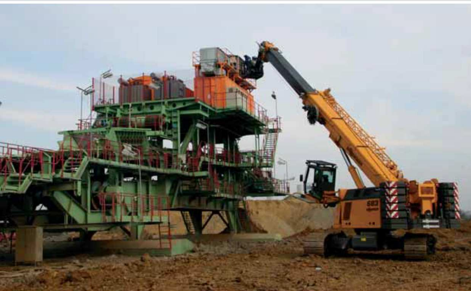
683 R - Installations- und Inspektionsarbeiten mit Arbeitsbühne im Tagebau; Serbien 683 R - Installations- und Inspektionsarbeiten mit Arbeitsbühne im Tagebau; Serbien
