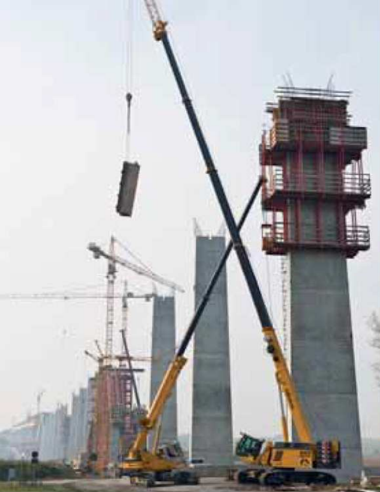
683 R - Hoisting construction planks; Germany 683 R - Hebearbeiten von Verschalungsteilen; Deutschland
