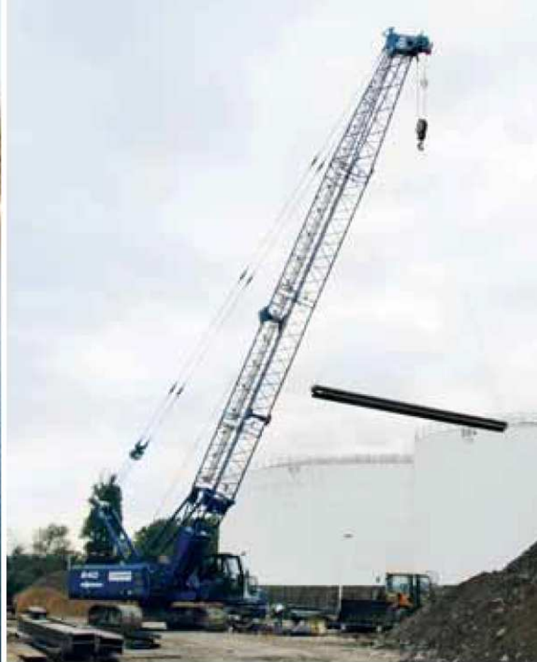
640 HD - Hoisting operation; Germany 640 HD - Hebeinsatz; Deutschland
