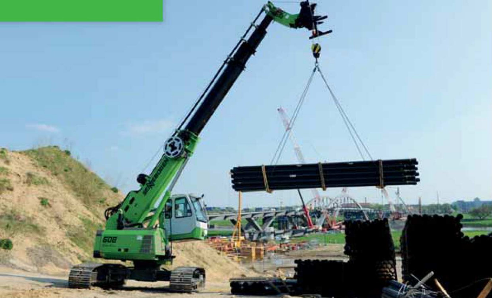
608 R – Hoisting works on construction site; Germany 608 R – Hebearbeiten im Baustelleneinsatz; Deutschland
