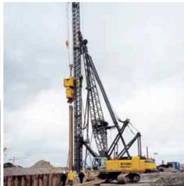
6100 HD - With leader and vibrohammer powered by the crane 6100 HD - Mit Mäkler und Rüttler angetrieben durch den Bagger
