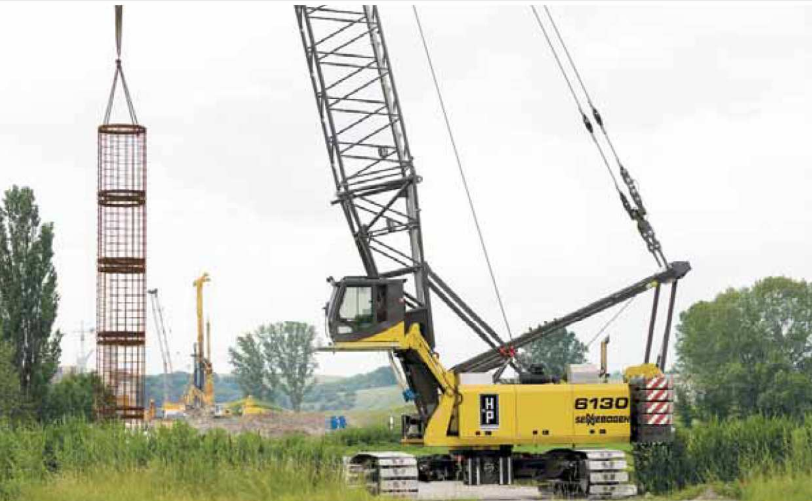
6130 HD - Foundation works; Germany 6130 HD - Grundierungsarbeiten; Deutschland
