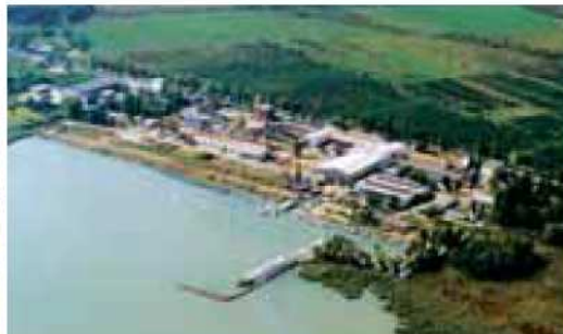
Works Balantonfüred/Hungary - welding/steel construction Werk Balantonfüred/Ungarn - Schweiß-/Stahlbaugruppen
