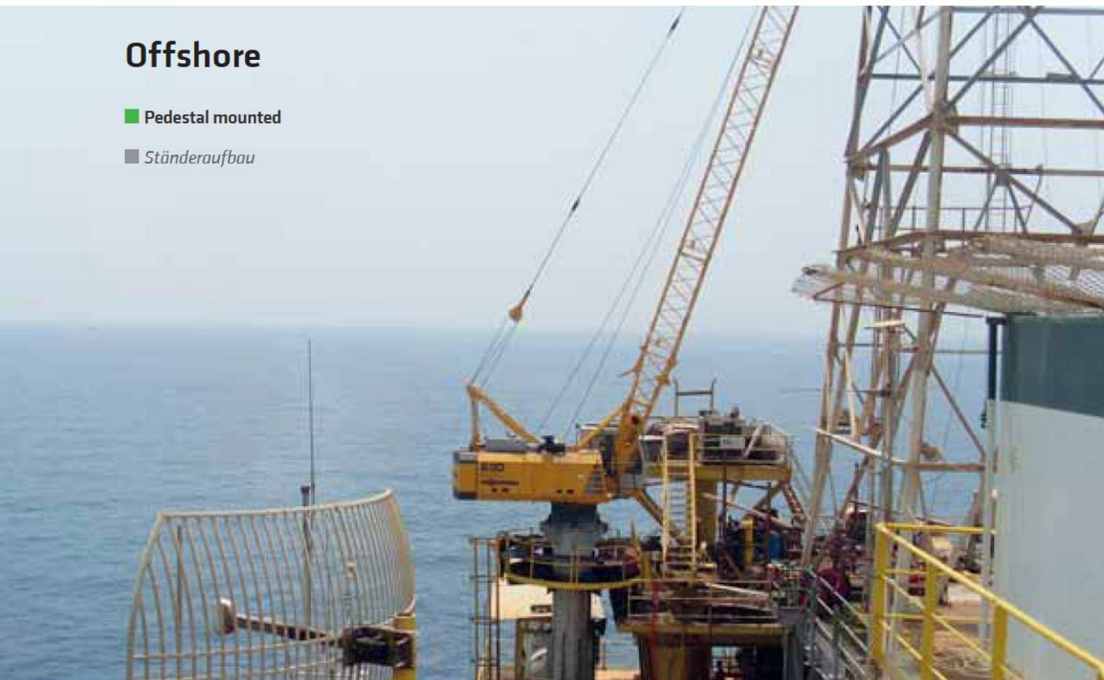
630 HD – Mounted on oil platform hoisting works for offshore application; Iran 630 HD – Hebearbeiten auf Offshore Ölplattform; Iran
