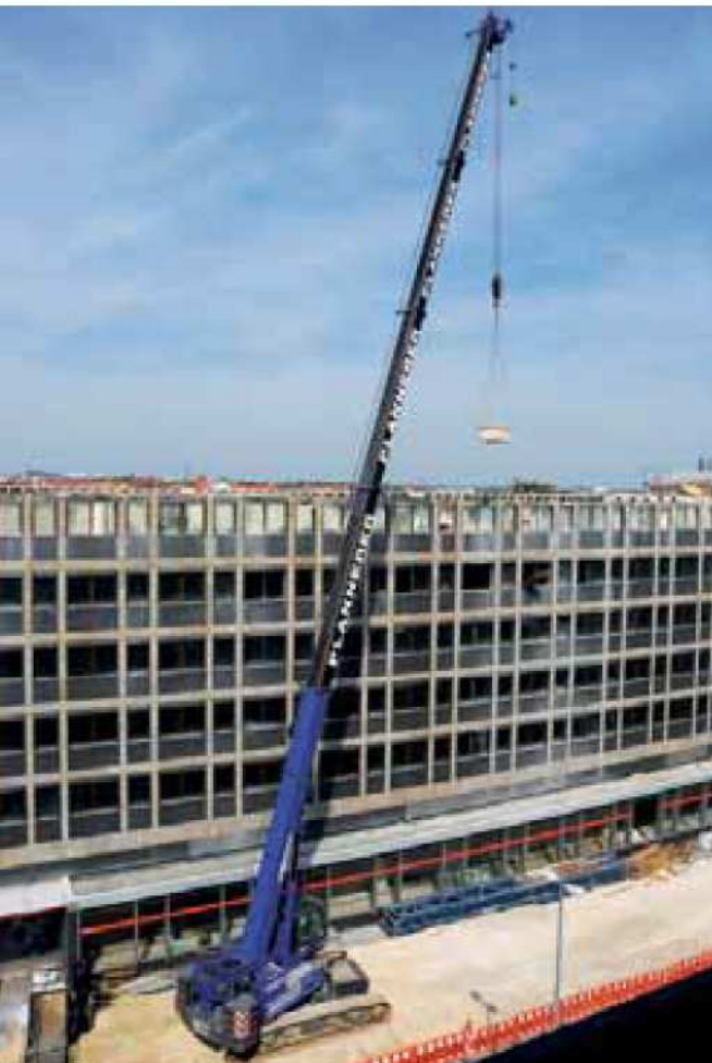
683 R - Deconstruction works; Germany 683 R - Rückbauarbeiten; Deutschland
