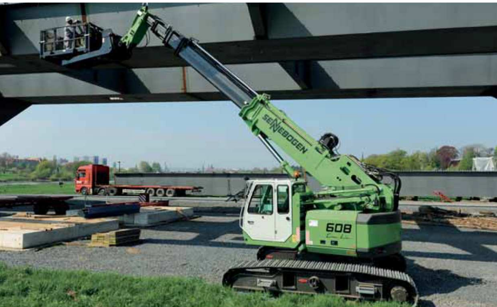
60 608 R – Inspection of bridges with 360° working platform; Germany 608 R – Inspektion von Brücken mit 360° Arbeitsplattform; Deutschland
