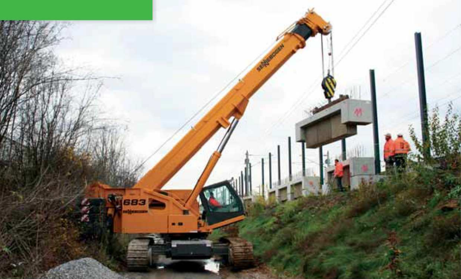
683 R - Hoisting prefabricated concrete elements; Germany 683 R - Hebearbeiten von Beton-Fertigteilen; Deutschland
