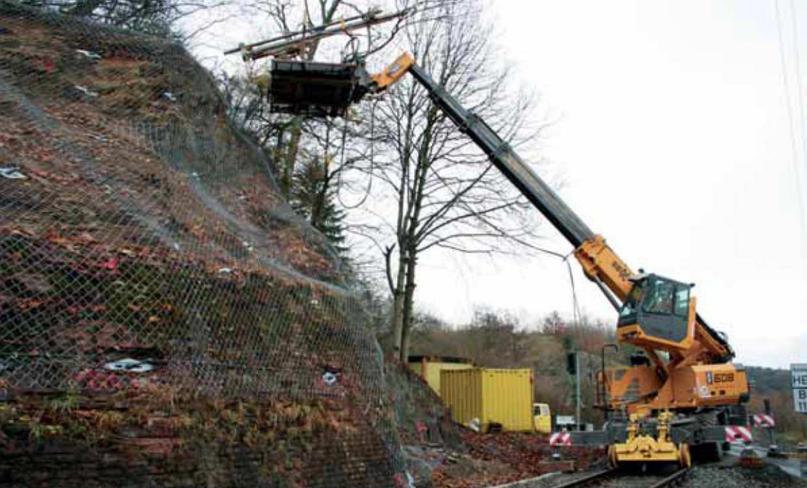
608 M - In two-way operation: fixation of safety nets along rails; Germany 608 M - im Zwei-Wege-Betrieb: Fixierung von Fangnetzen entlang Bahnstrecke; Deutschland
