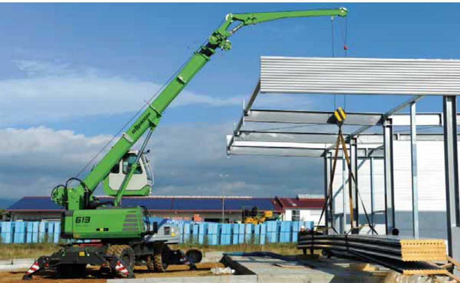
613 M - Hoisting of prefabricated wall elements for assembly; Germany 613 M - Verheben von Wandelementen bei der Fertigteilmontage; Deutschland
