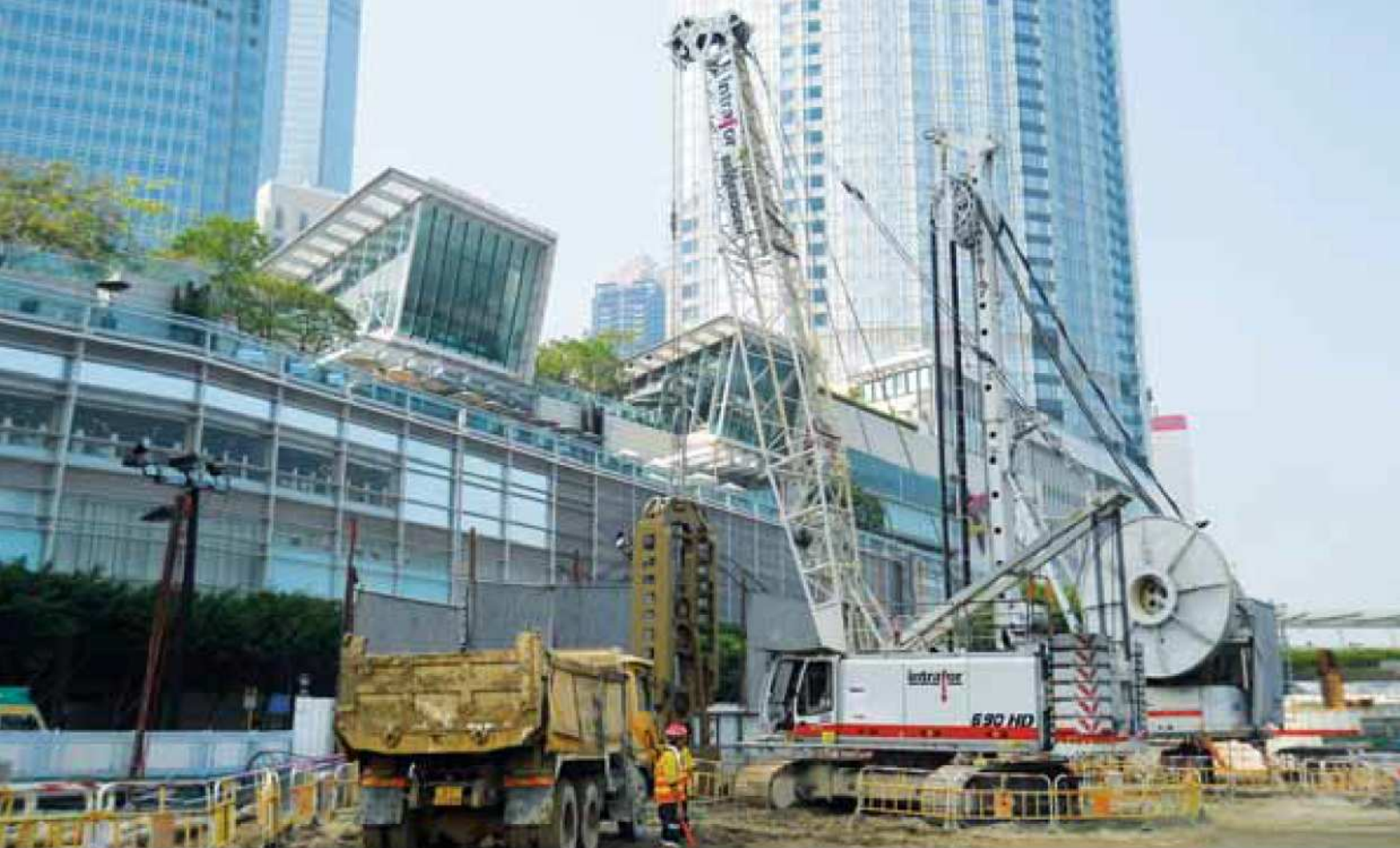
690 HD - With mechanical diaphragm wall grab; Hong Kong 690 HD - Mit mechanischem Schlitzwandgreifer; Hong Kong
