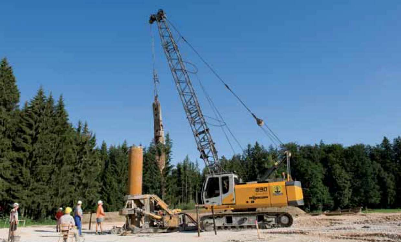
630 HD - With casing oscillator driven by on board hydraulics; Austria 630 HD - Maschine mit integriertem Zusatzhydraulikpaket im Brunnenbaueinsatz mit Verrohrungsmaschine; Österreich
