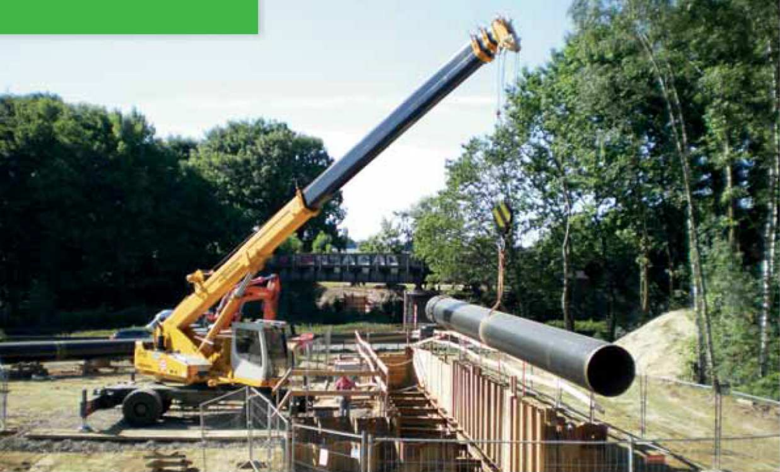
643 M – Pipe installations works; Germany 643 M – Rohrlegearbeiten; Deutschland
